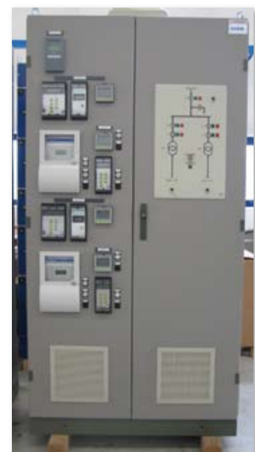
Quadro per campi eolici in Puglia
